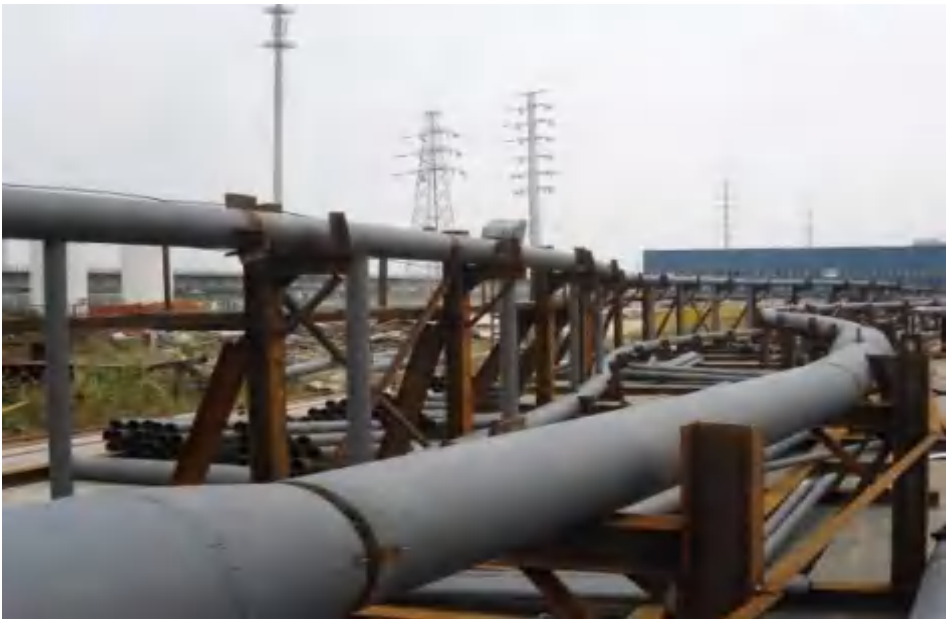
桁架梁地面拼装胎架
