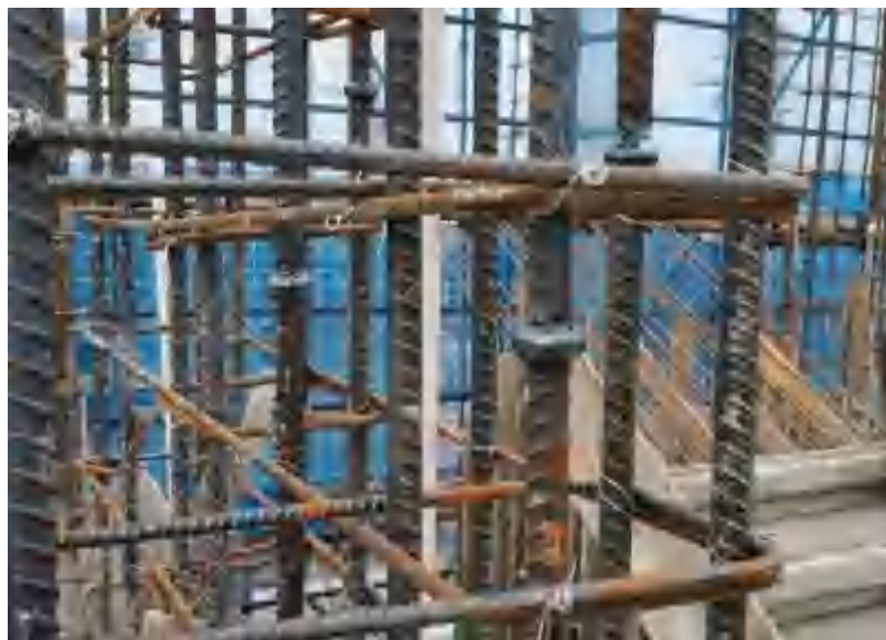
电渣压力焊连接
