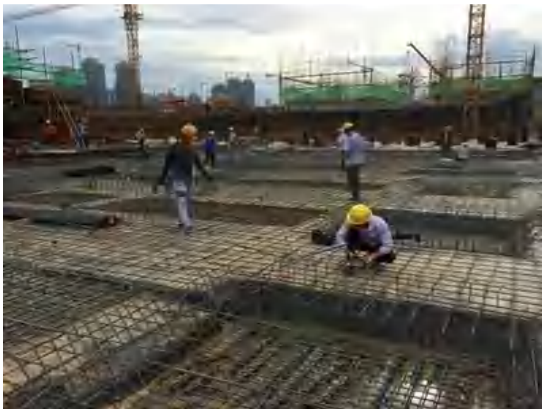
基础筏板钢筋绑扎
