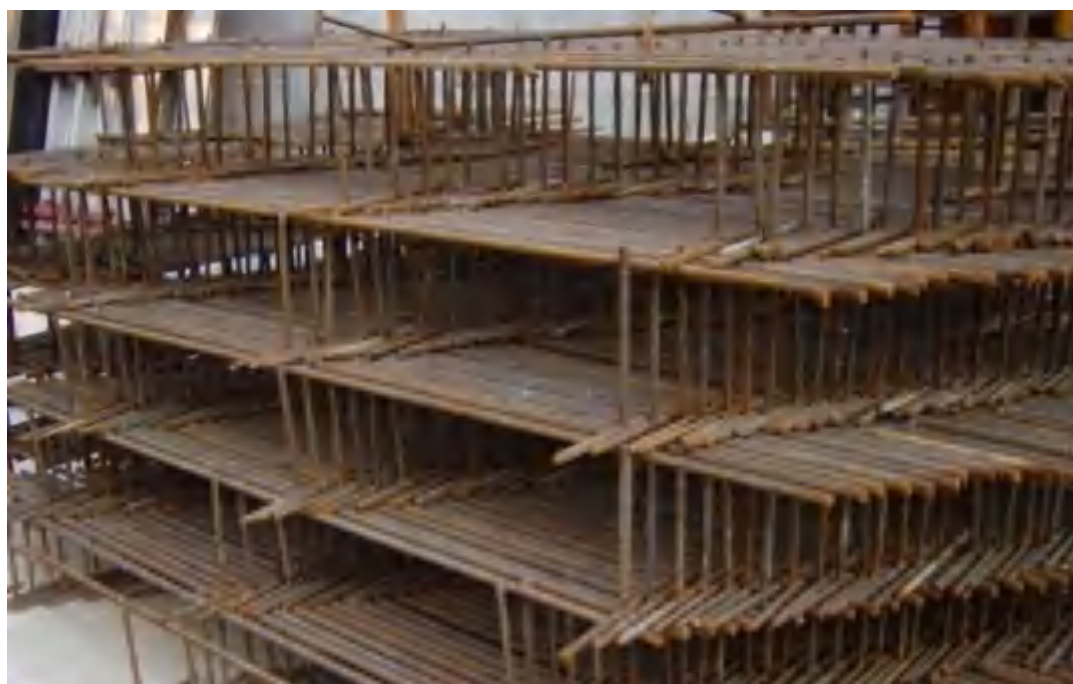
短钢筋焊接施工马凳
