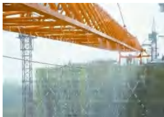
塔吊降尘喷淋系统
