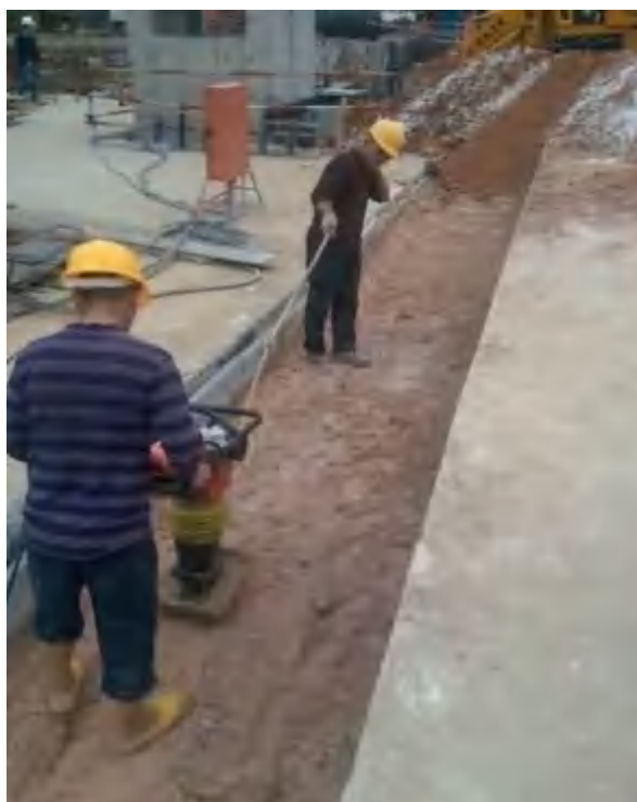
基坑土方回填
