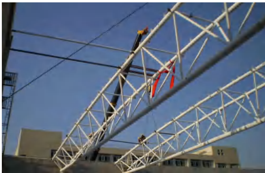
三管立体桁架示意 1
