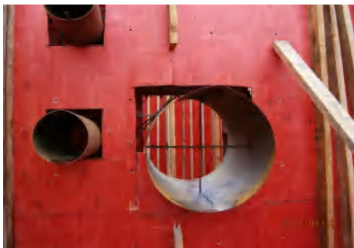
穿墙管道预埋示意图
