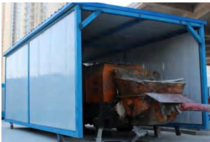
混凝土输送泵降噪棚
