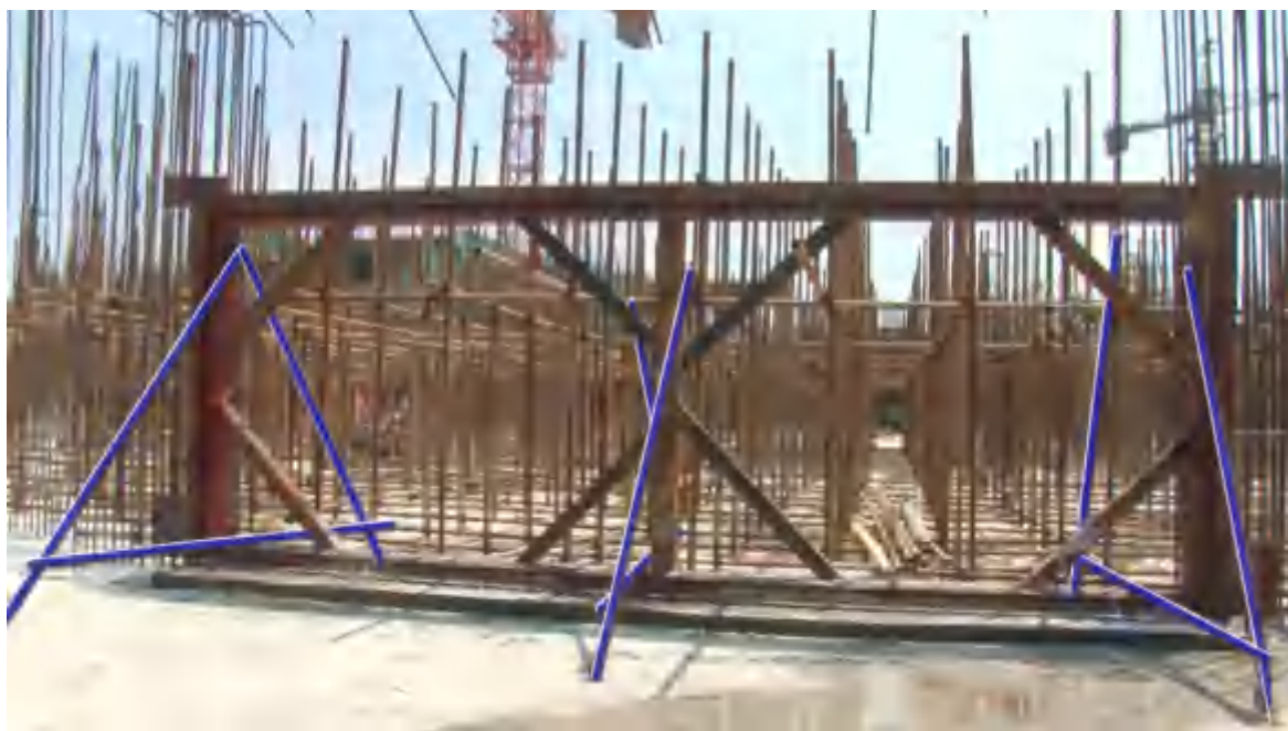
人防门框安装支撑示意图
