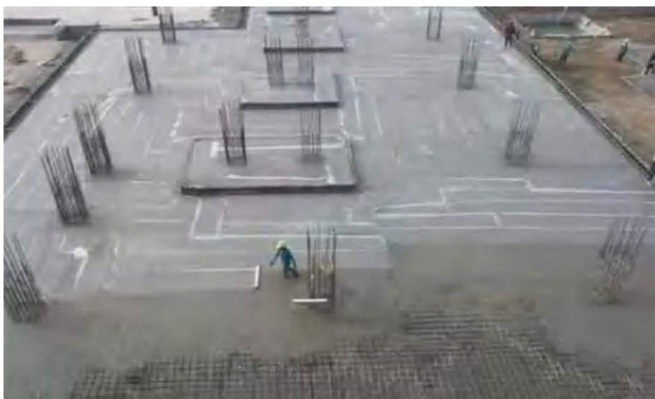
筏板基础混凝土养护
