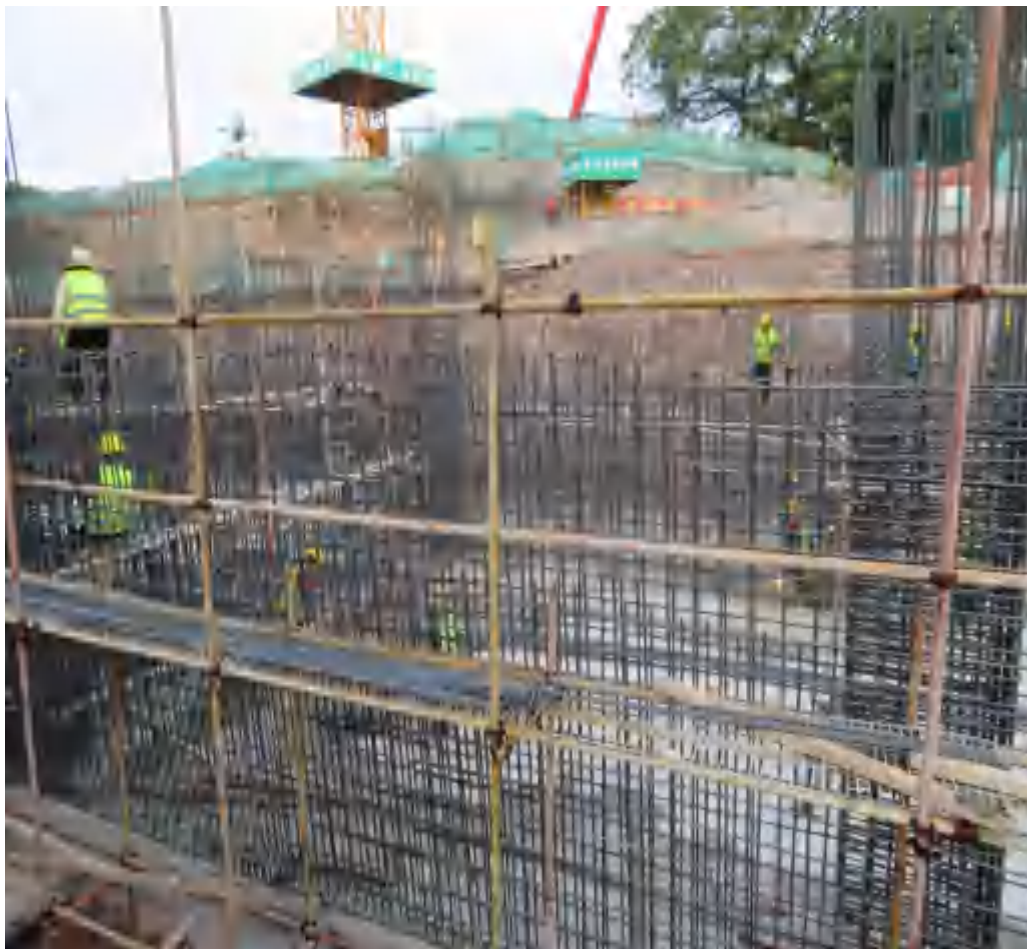
剪力墙钢筋绑扎
