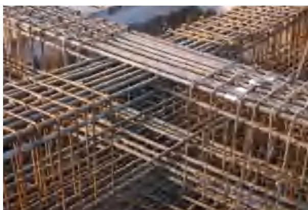
钢筋直螺纹连接
