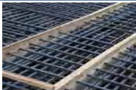
板后浇带侧面模板图
