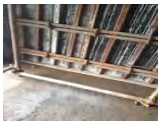
墙柱模板底部压脚板图
