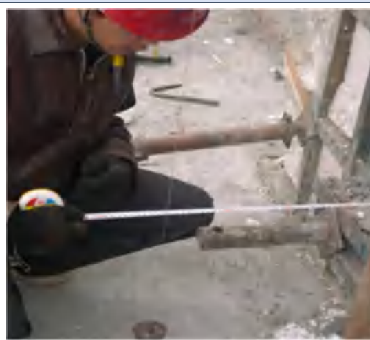
墙体模板吊锤实测
