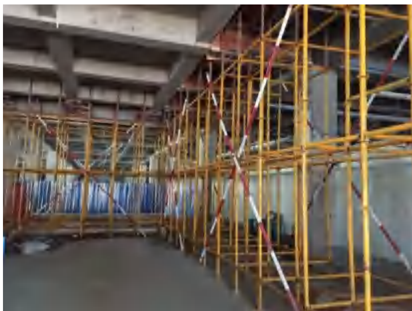
楼板后浇带独立支撑架体实例
