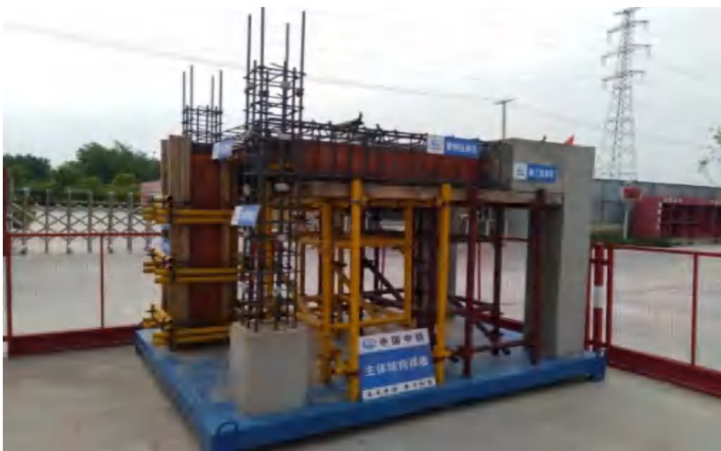
柱、梁、板钢筋样板展示
