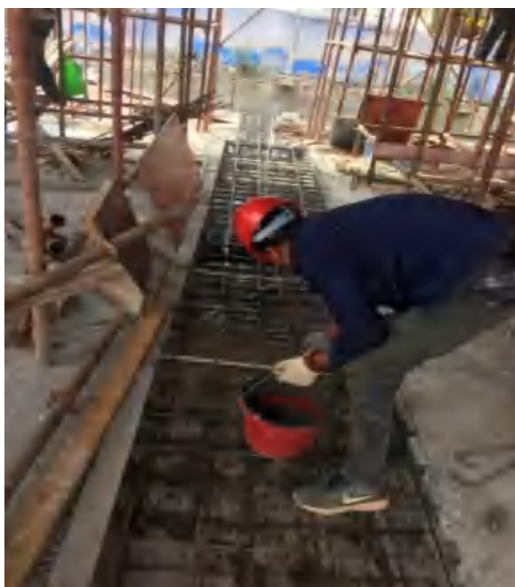
后浇带裸露钢筋处理
