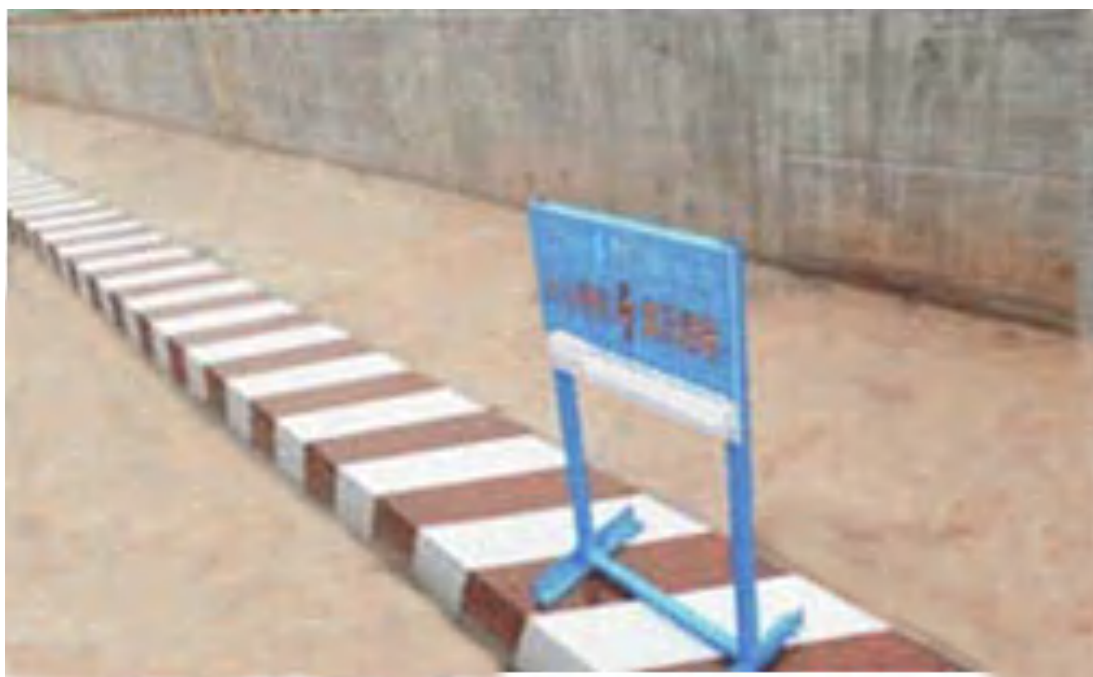
废旧模板作电缆防护盖板
