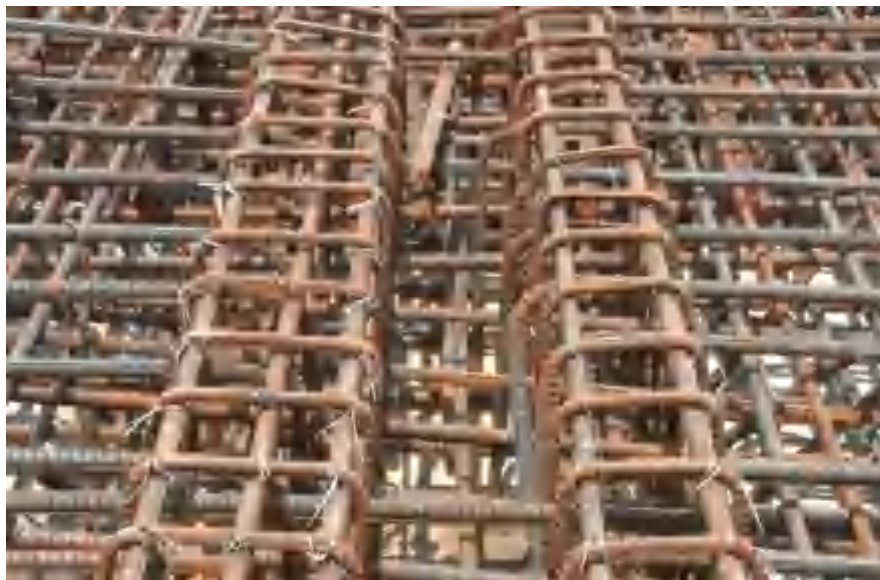
人防底板钢筋绑扎示意图
