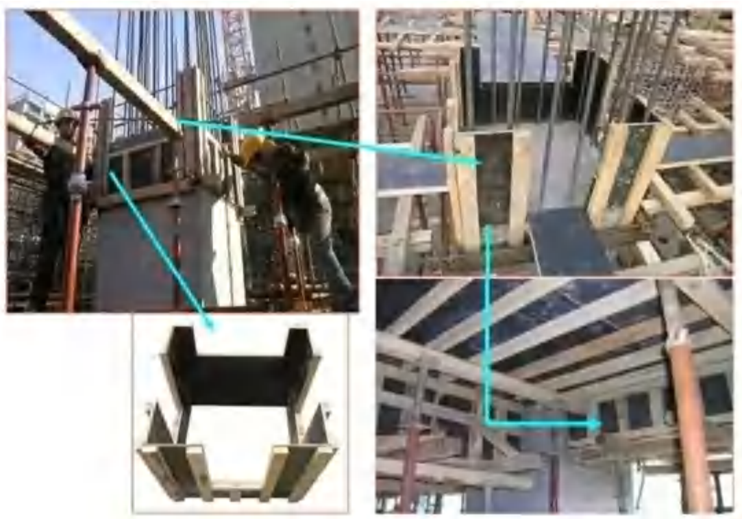
梁柱接头处理实例
