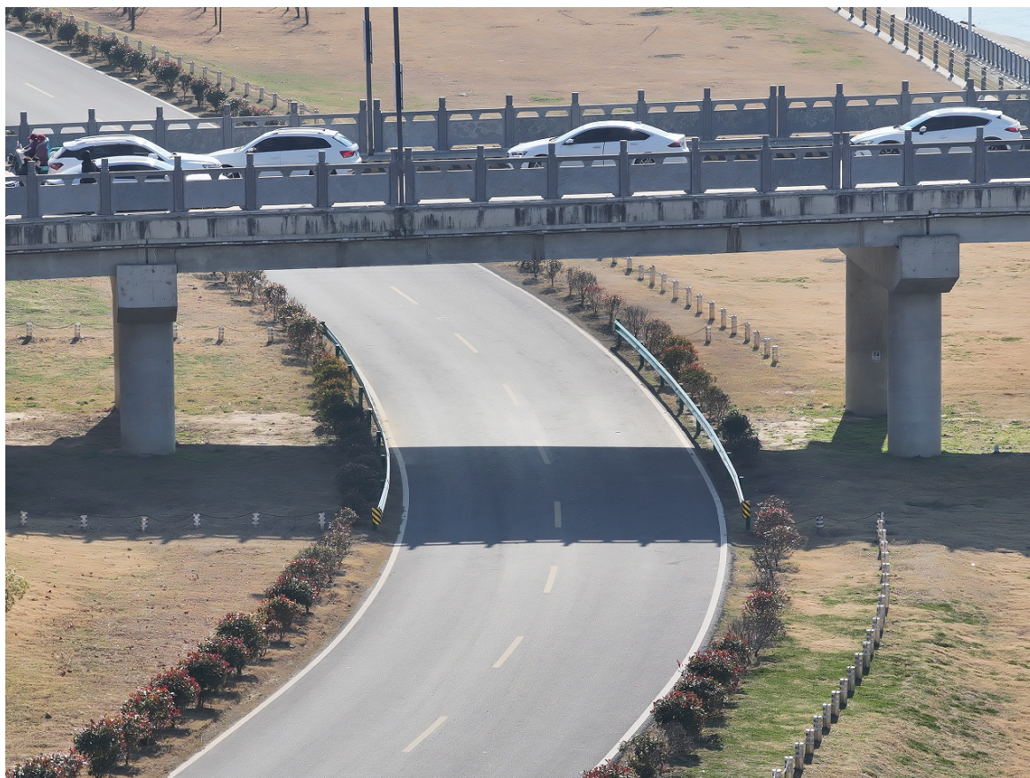
上下堤道路护栏接长
