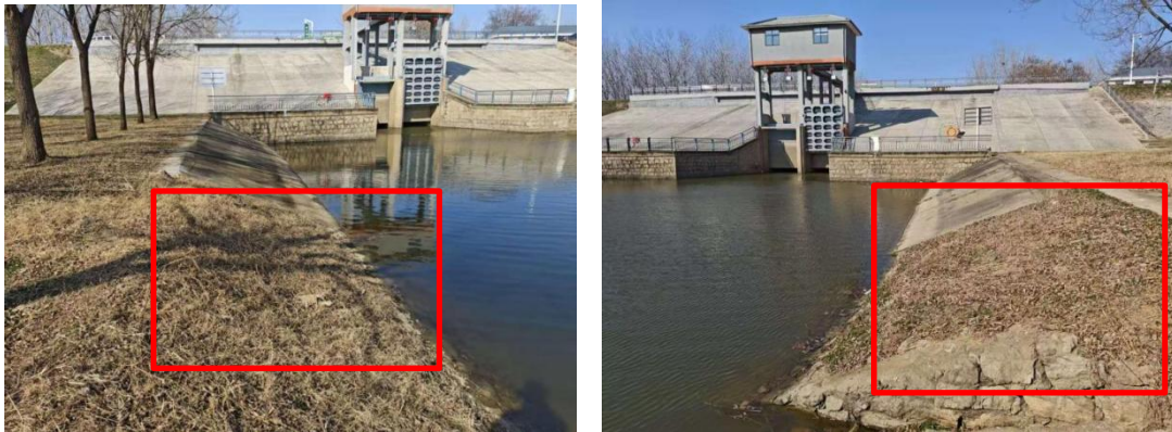
架河闸淮河侧大沟坡面
