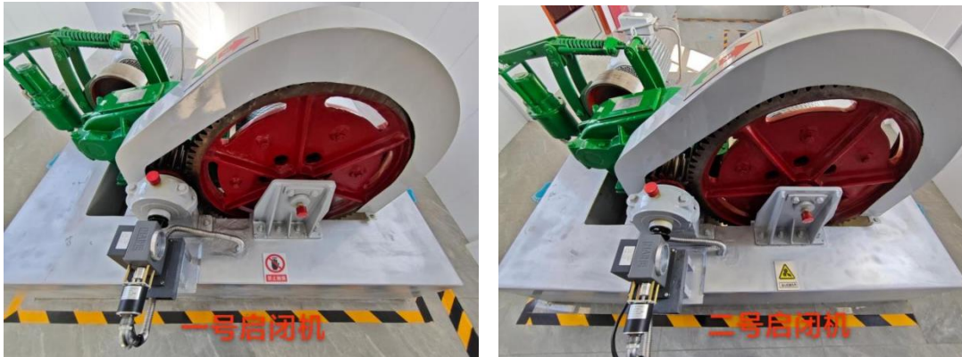
架河闸启闭机
