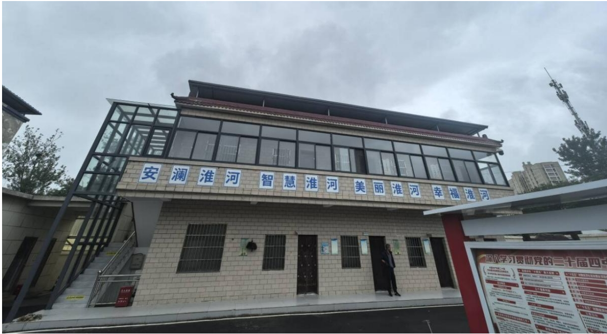
办公楼顶现状
