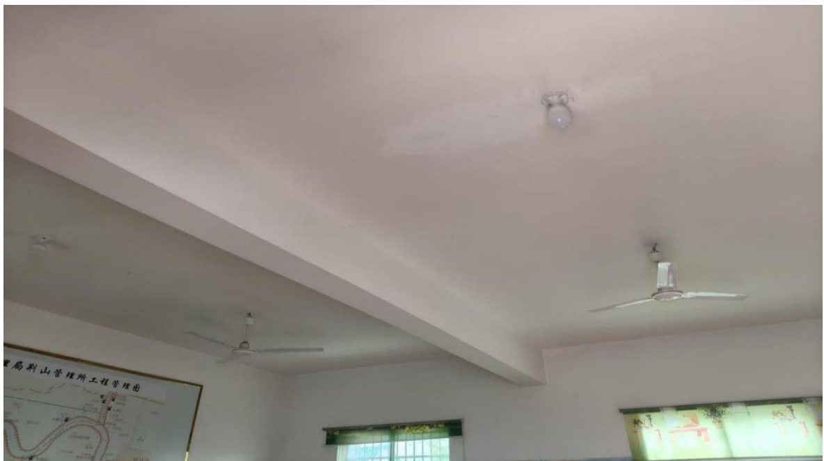
会议室屋顶现状
