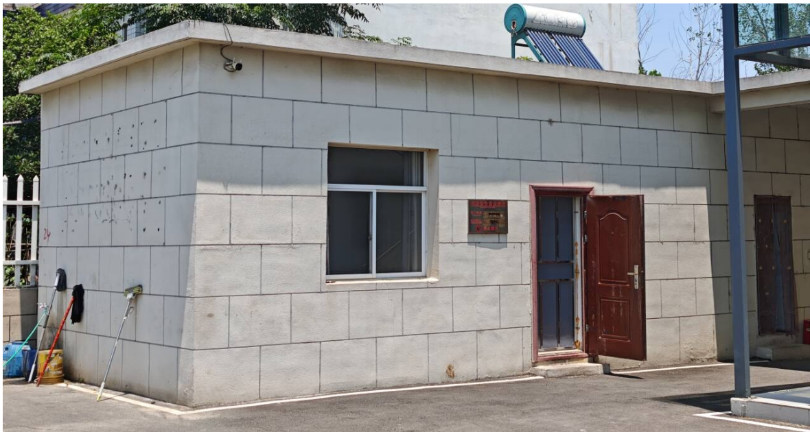
屋顶新增树脂瓦斜屋面
