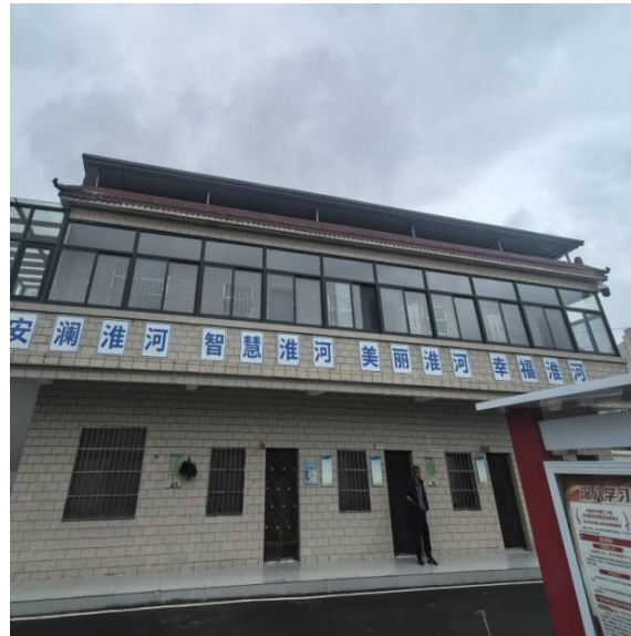
屋顶新增树脂瓦斜屋面
