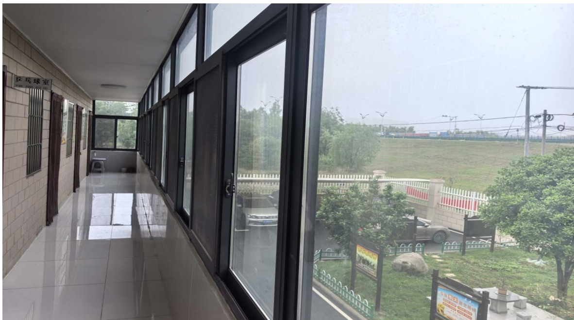
二楼阳台现状
