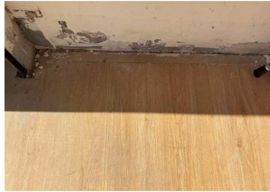
管理用房墙皮、真石漆脱落
