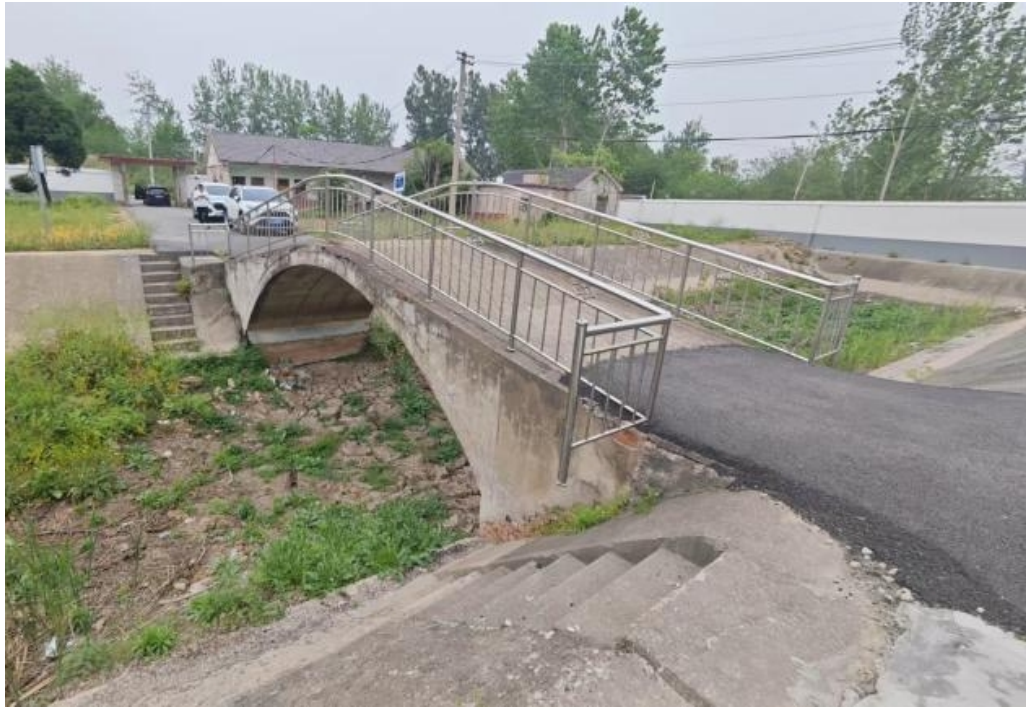
院内拱桥现状
