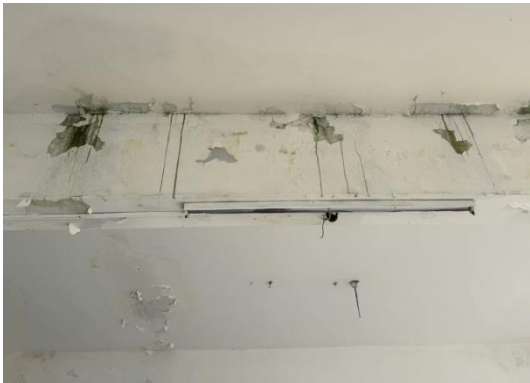
屋顶漏水严重
