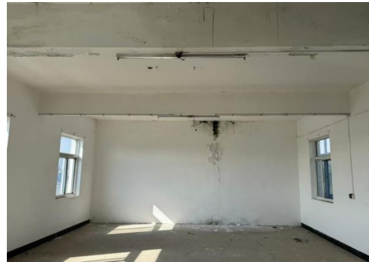
屋顶漏水严重
