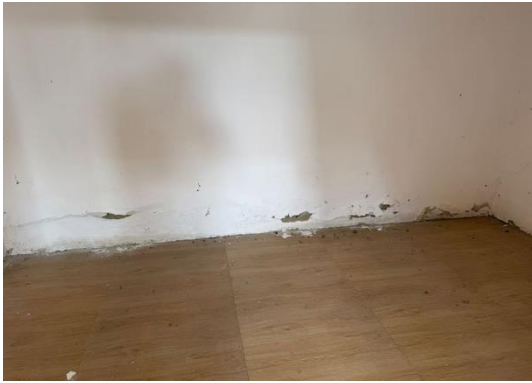
管理用房墙皮、真石漆脱落
