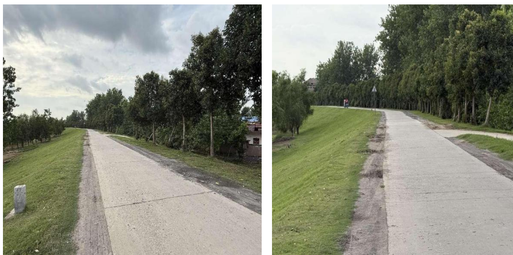
涡左堤 42+350-43+400 堤顶路面
