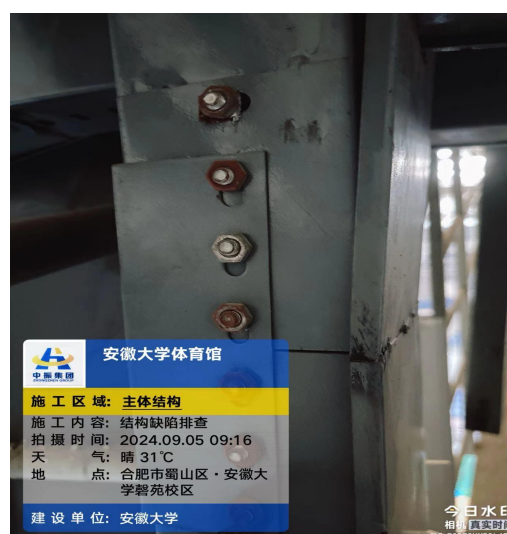
马道结构锈蚀
