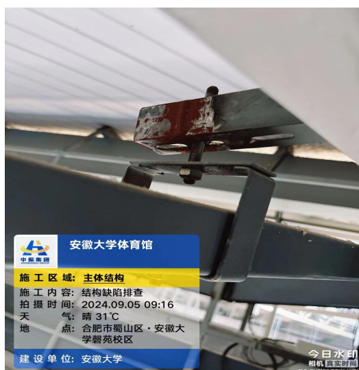
马道结构锈蚀
