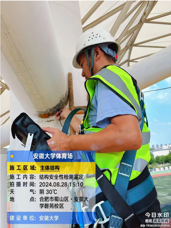
焊缝超声探伤检测
