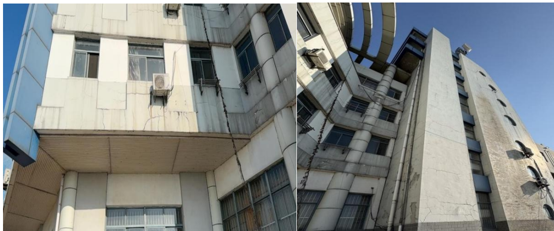
荆山湖退洪闸启闭机房湖内侧外墙
