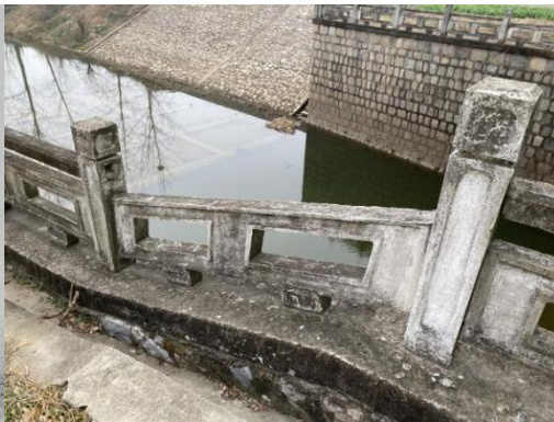
混凝土护栏损坏
