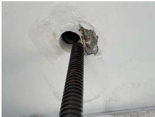
涵闸顶部渗水涂料脱落
