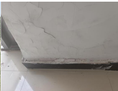
室内墙面涂料脱落
