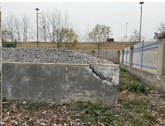
防汛料场围墙开裂与位移现状
