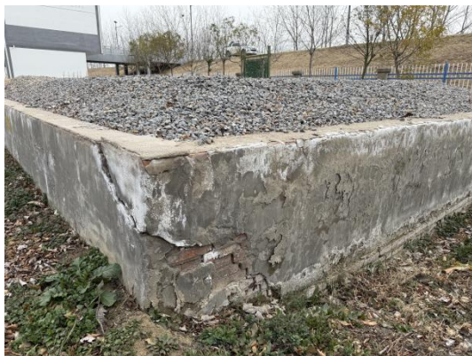
防汛料场围墙开裂与位移现状
