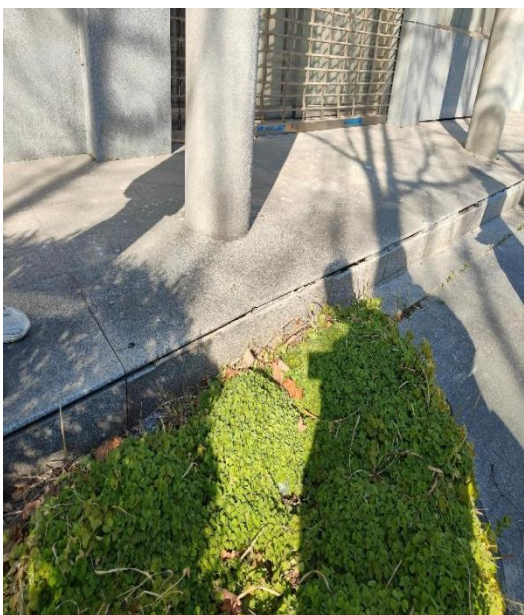
图 2 外侧地砖破损脱落
