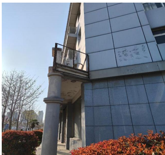
图 3 外立面脱落
