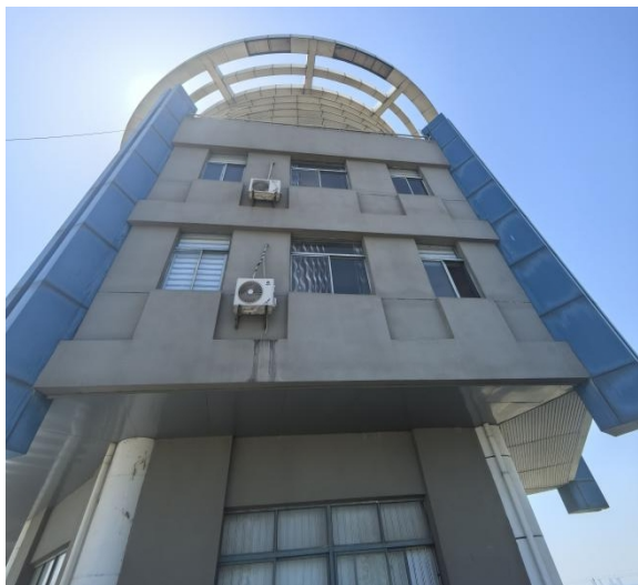
高空铝塑板脱落情况(修复作业点距地面高度约 20m)
